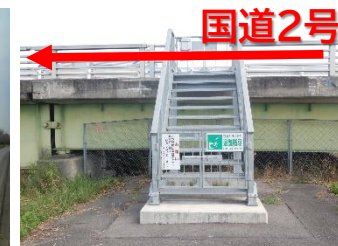
▲整備状況(③箇所)
