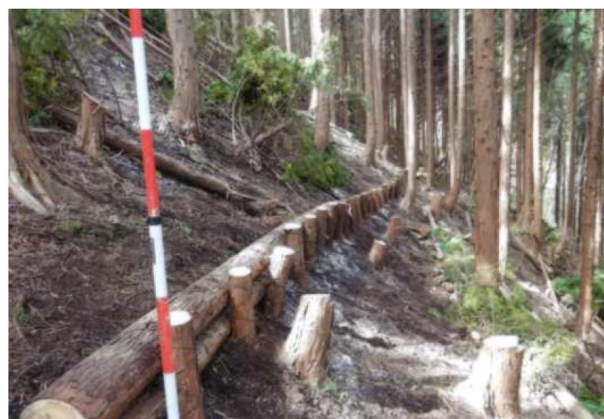
丸太筋工の実施状況
