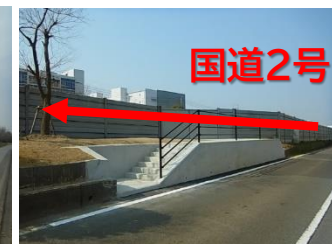
▲整備状況(③箇所)
