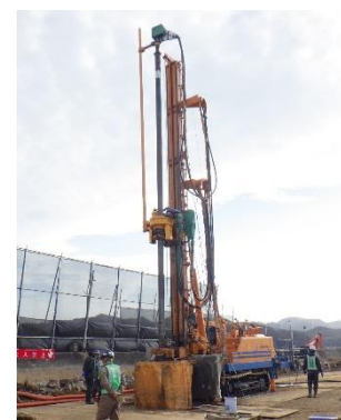
耐震対策の施工状況 (九蟠地区)
