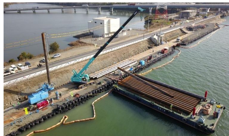
高潮・耐震対策の様子(鶴新田)
