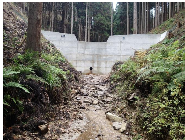
溪間工の施工状況
