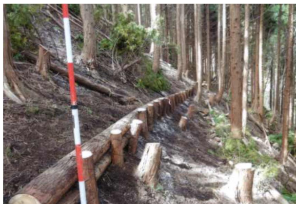
丸太筋工の完了状況
