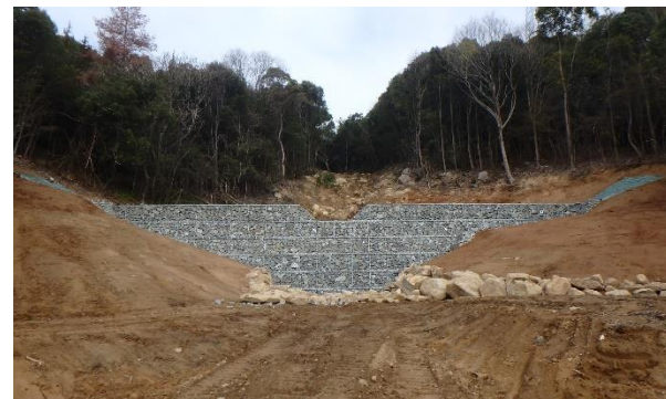
H31加賀山災害復旧工事(溪間工1基)
