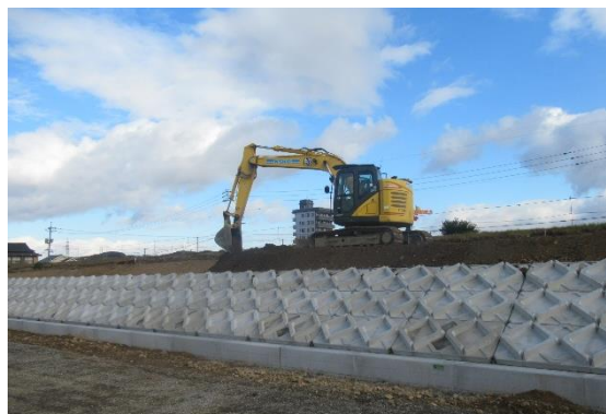
築堤の施工状況 (平井地区)
