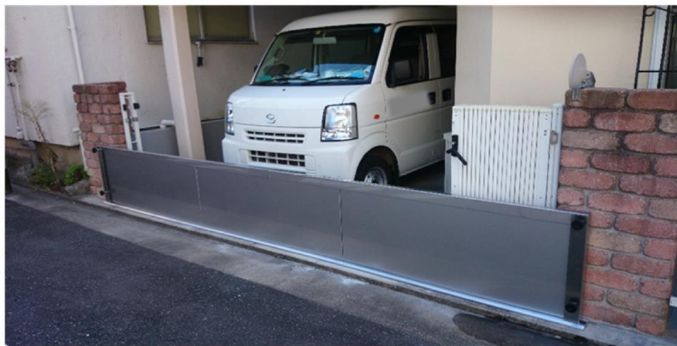
【止水板の設置例】
