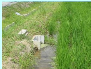
堰板等設置風景①
