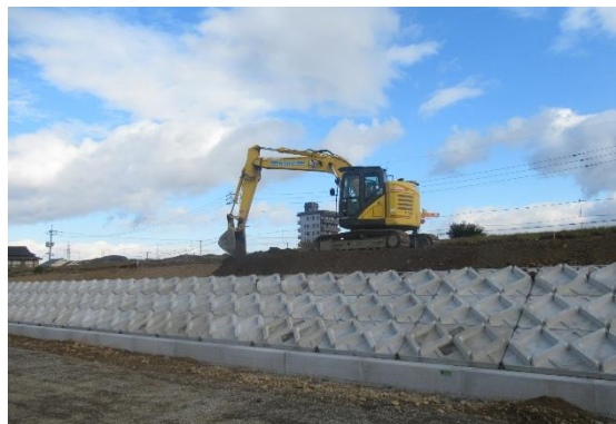
築堤の施工状況 (平井地区)
