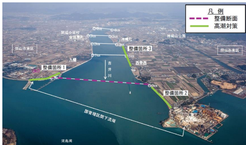
高潮対策区間(九蟠・西幸西地区)
