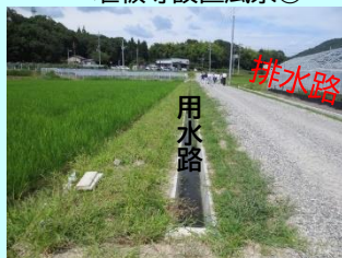
堰板等設置風景②
