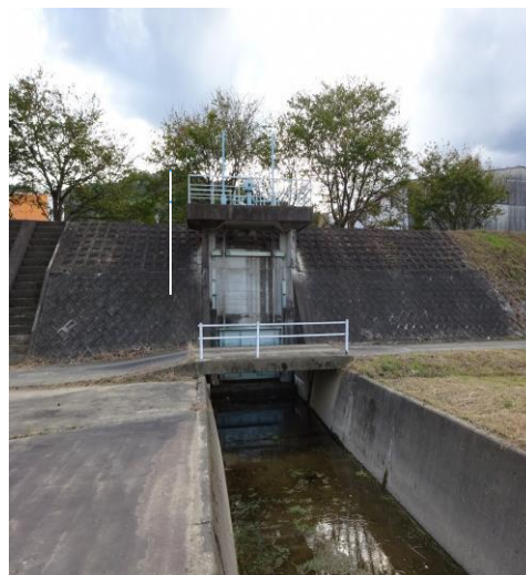
施工前（第2ポンプゲート）
