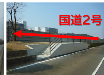
▲整備状況(③箇所)
