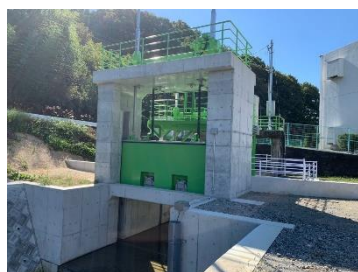
南部排水ポンプ場 (R4新設)
