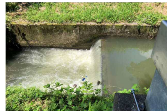
古地取水転倒堰の事前操作
