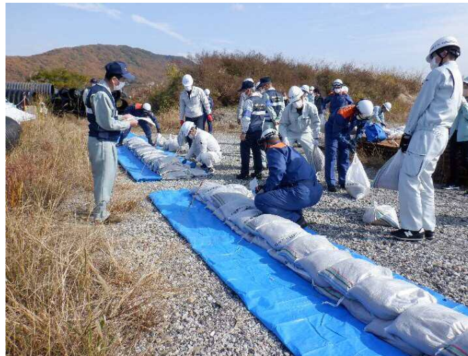
改良積み土のう工法
