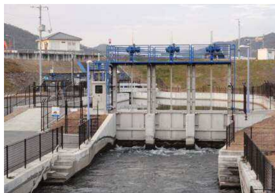
湛井堰ゲートの事前操作
