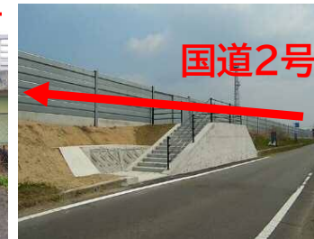
▲整備状況(②箇所)
