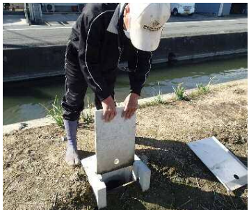
堰板等設置状況(ほ場)
