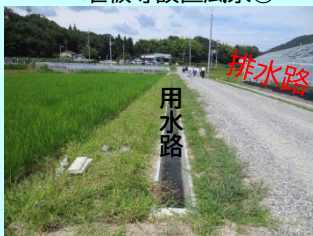
堰板等設置風景②
