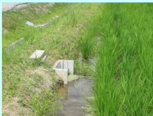
堰板等設置風景①
