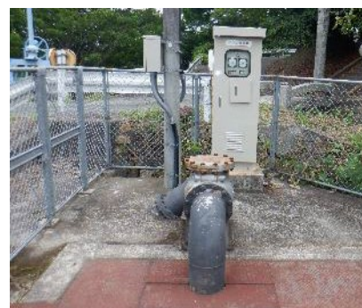
ポンプ本体・制御盤の更新
