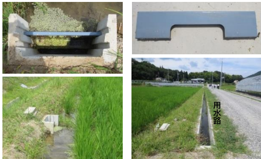
堰板等設置風景
