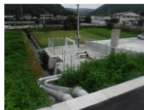
西町排水ポンプ場
