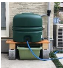
雨水タンク設置事例
