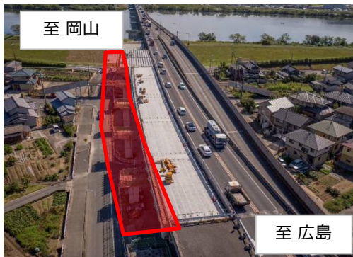
《見学箇所（架設現場）》
