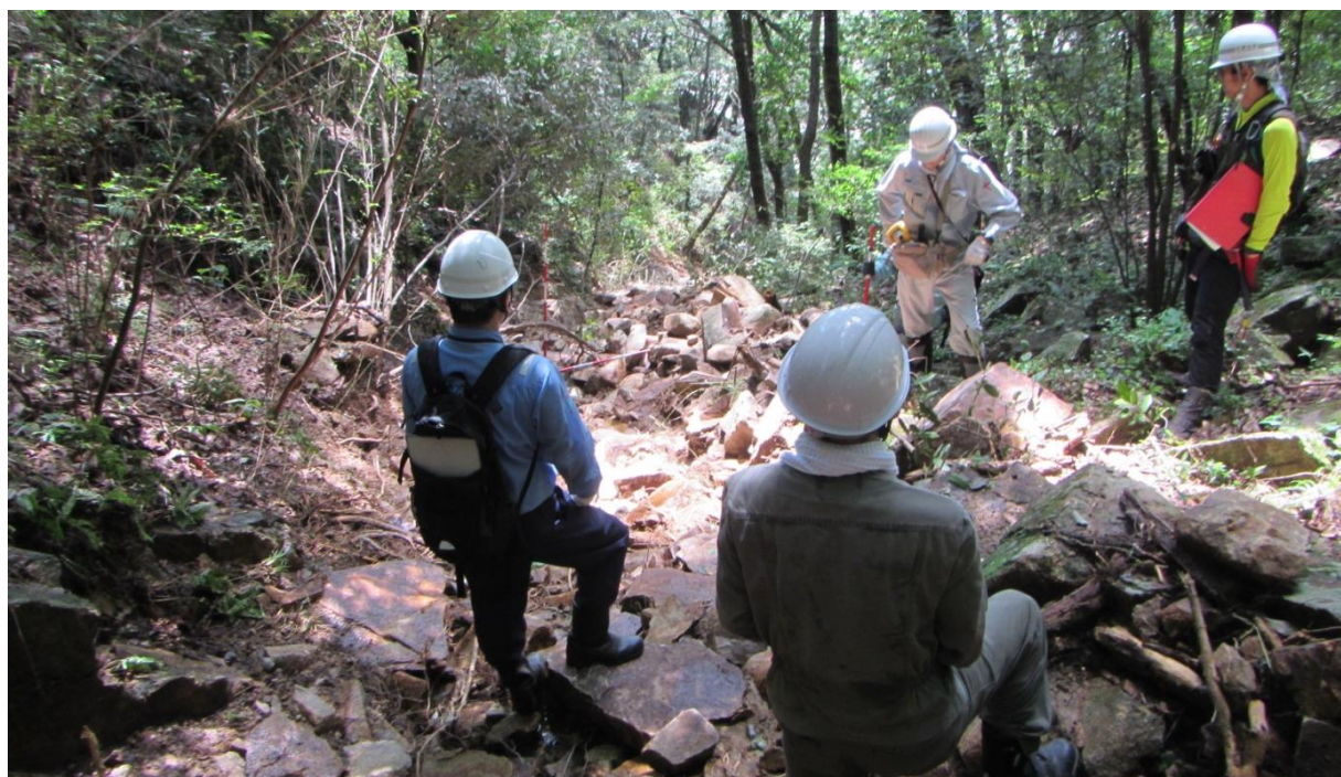
△総社市井尻野の道路上の斜面にて、落石等の二次被災がないか確認
