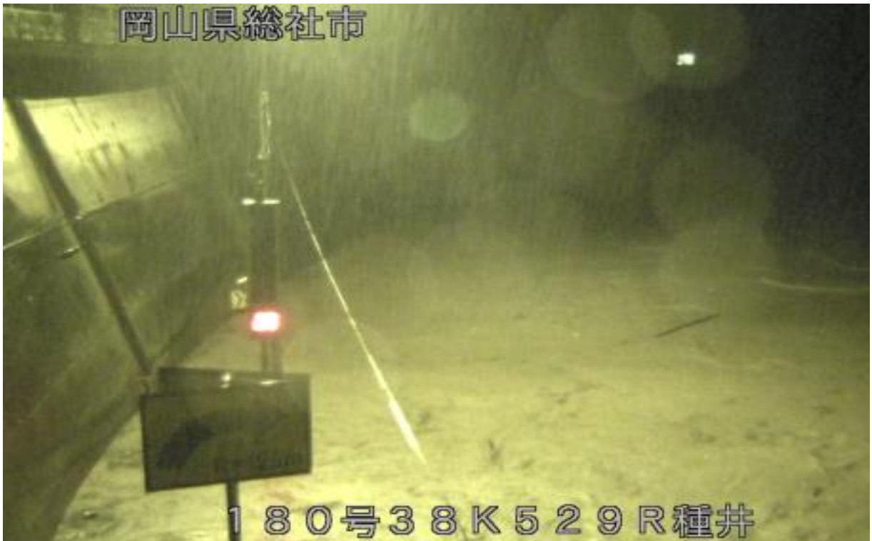
△総社市種井における CCTV 画像
