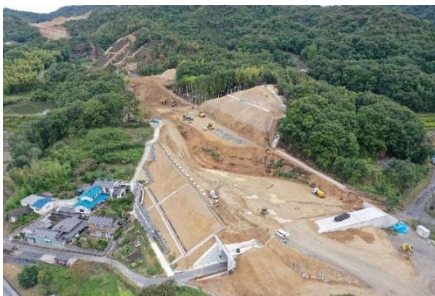
《施工現場写真》
