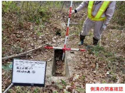
側溝の閉塞確認
