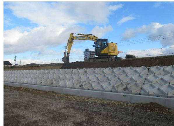
堤防整備の状況
