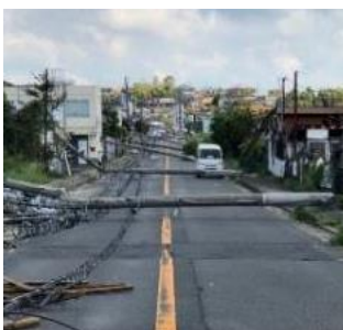
<電柱の倒壊による道路閉塞の事例>
