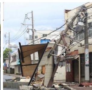
<飛来物による電柱倒壊の事例>
