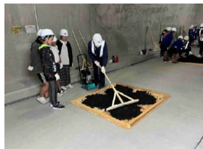
3) 舗装工事体験イメージ
