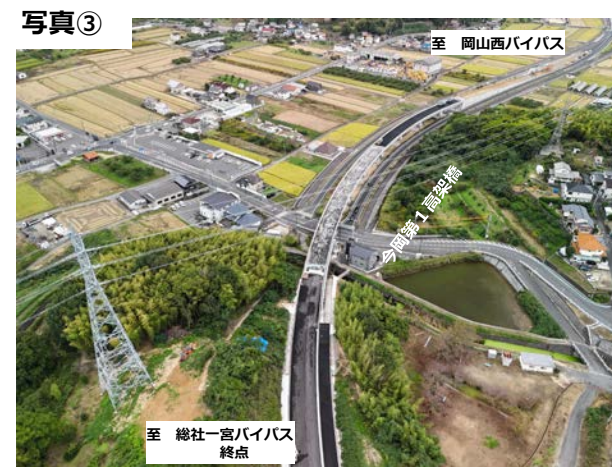
今岡第1高架橋付近 施工状況
