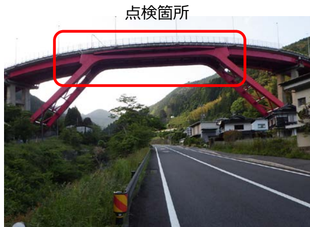
馬桑橋 南側からの状況
