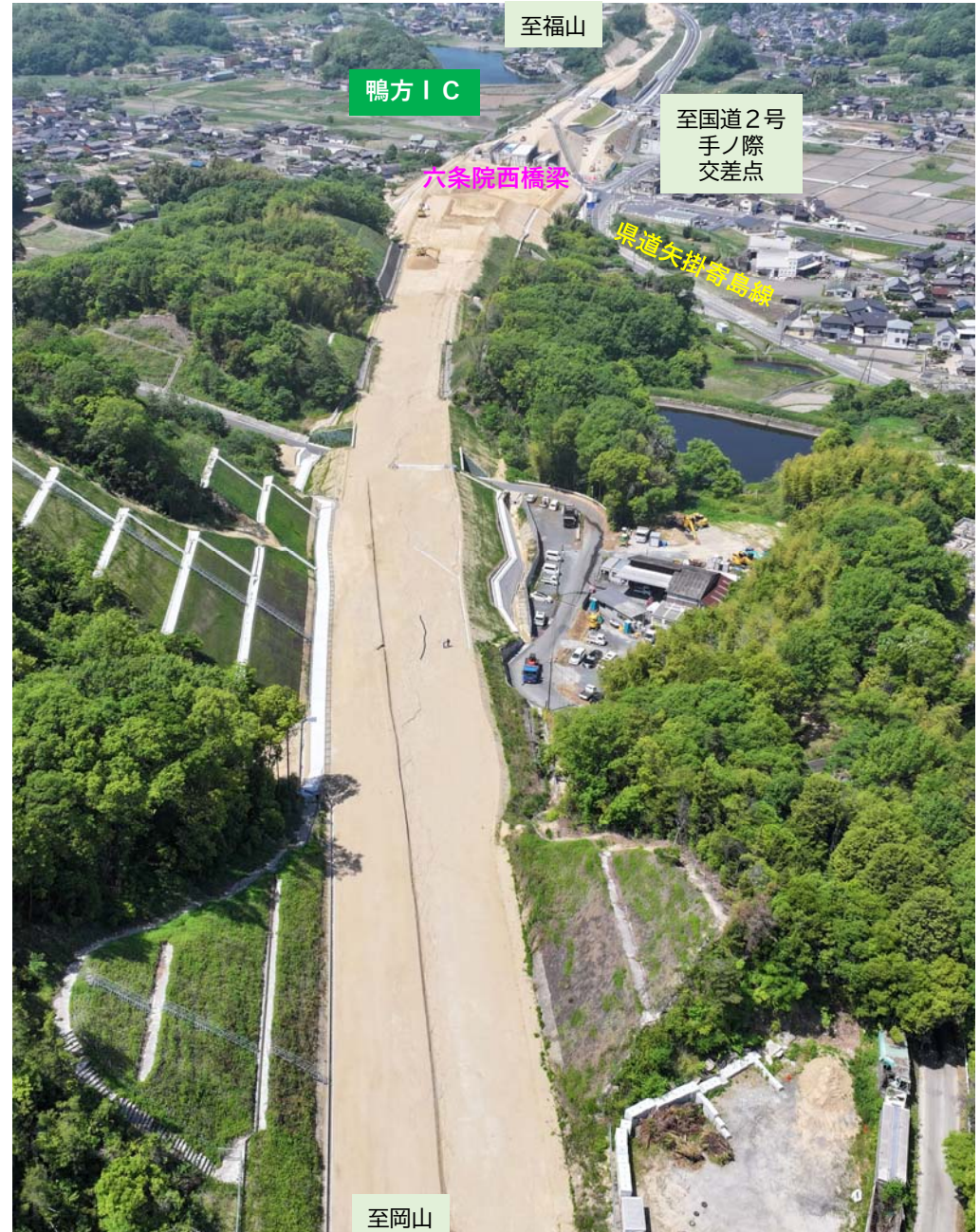
六条院西地区 施工状況
