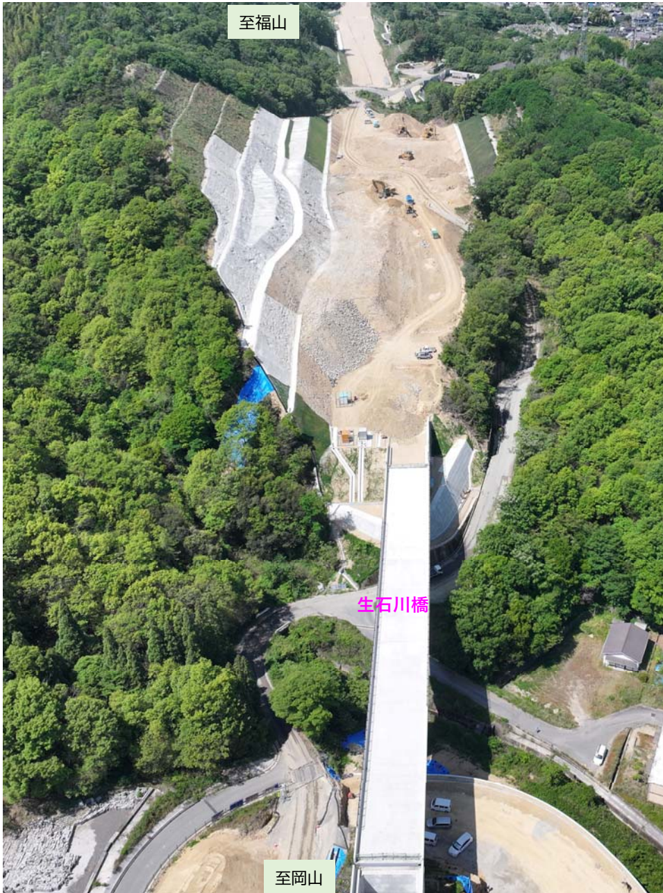
生石川橋付近 施工状況
