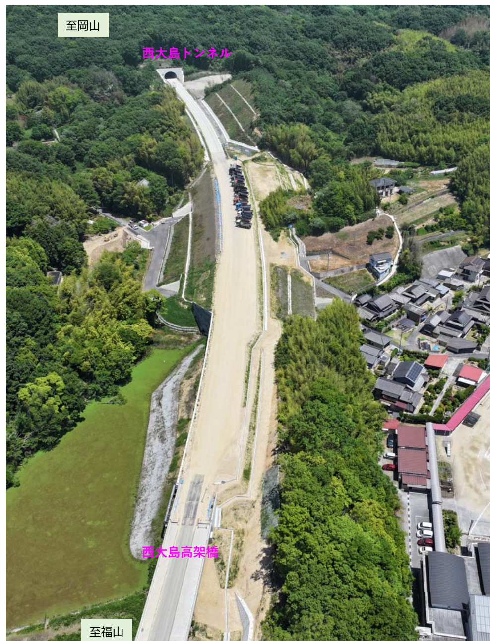
笠岡市西大島地区（2） 施工状況
