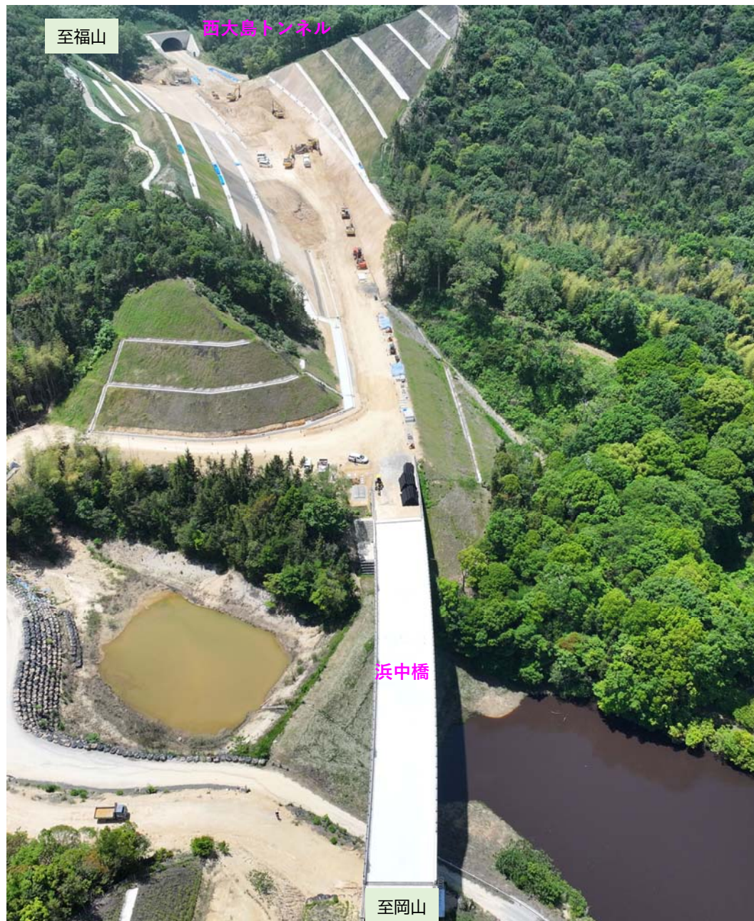
笠岡市西大島地区（1）（浜中西工区） 施工状況
