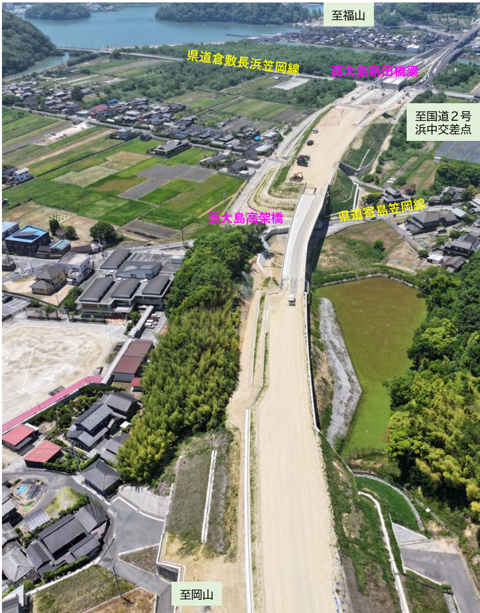
<406>県道寄島笠岡線付近 施工状況
