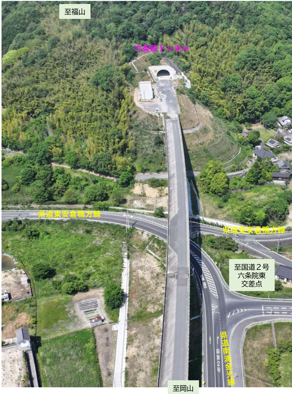
<284> 県道東安倉鴨方線付近 施工状況
