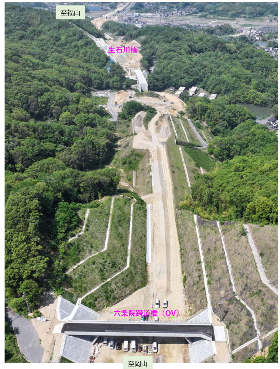
六条院中地区 施工状況
