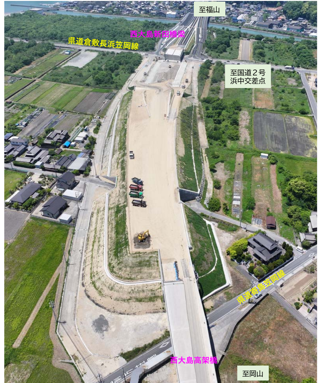
笠岡東IC付近 施工状況
