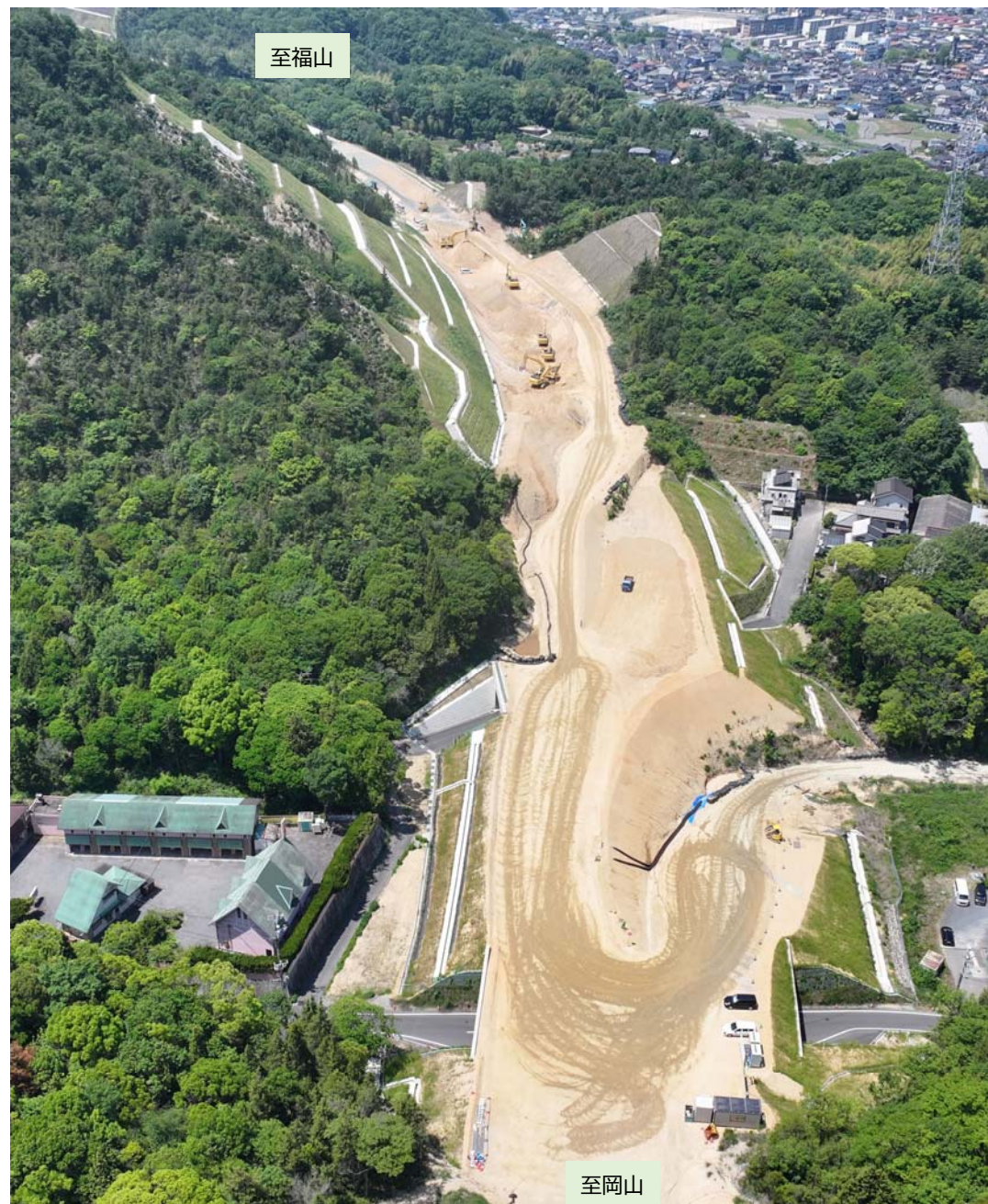
里庄町浜中（浜中中工区） 施工状況
