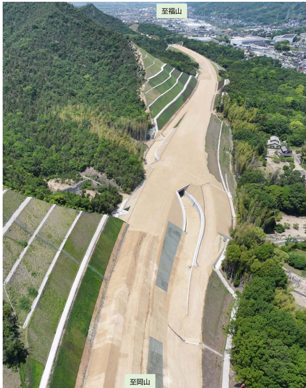
里庄町新庄（浜中東工区） 施工状況
