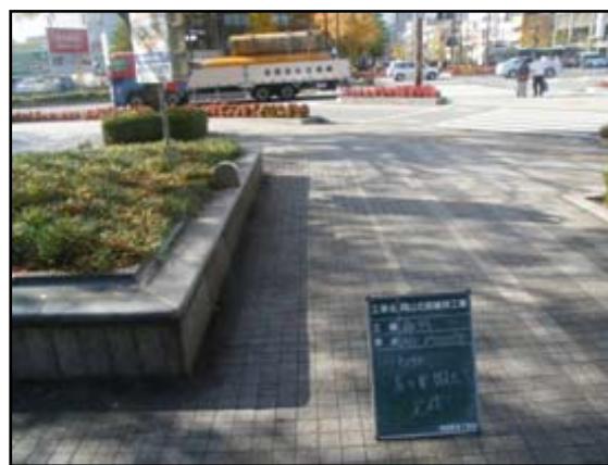
歩道清掃【清掃後】
