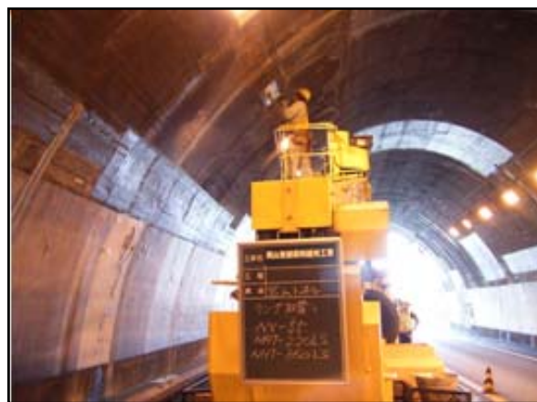
トンネル照明灯のランプ球替え
