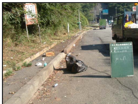
通常巡回(落下物処理)
