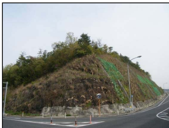
法枠による法面保護【対策前】
