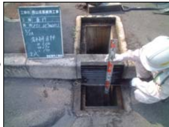
排水施設（構造物）清掃【清掃後】
