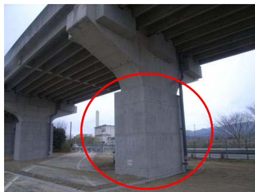
橋脚補強（RC巻立）【対策後】
