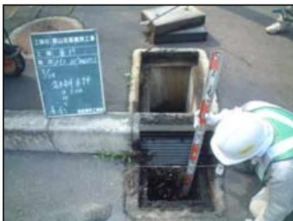
排水施設（構造物）清掃【清掃前】
