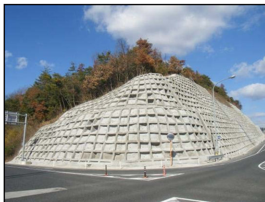
法枠による法面保護【対策後】
