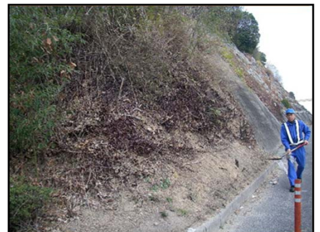
定期巡回(法面)
