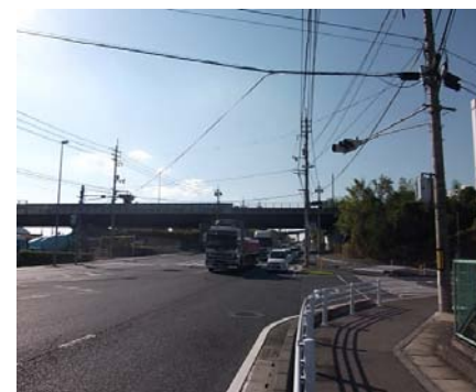
写真③ 一般国道179号
