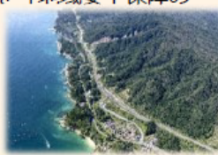
三陸沿岸道路（岩手県山田町）
