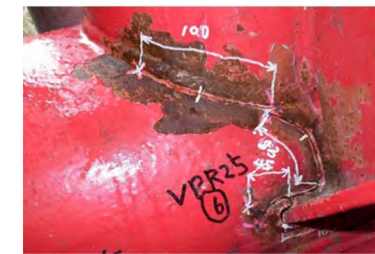
写真-1.4 下弦材とニーブレースフランジ (VPR25⑥)
