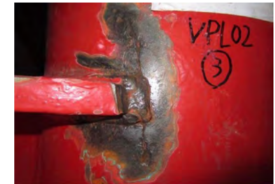
写真-1.2 垂直材と横桁上フランジ (VPL2③)
