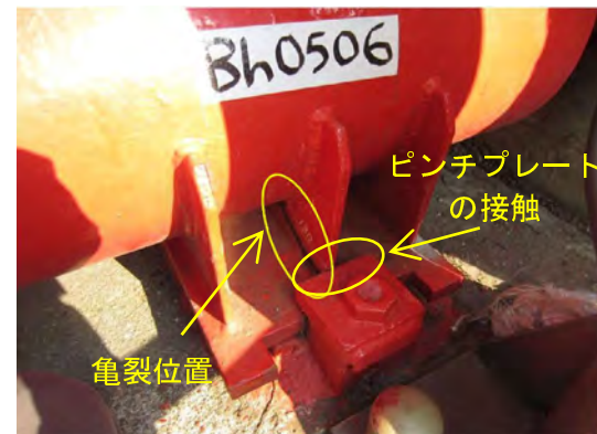
写真-4.1 補剛リブとピンチプレートの接触
