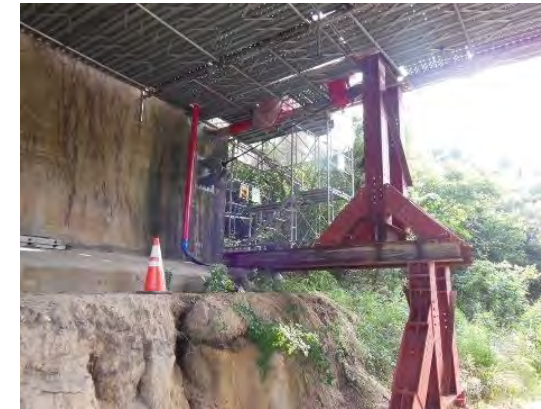
(a) 下弦材を支持する待ち受け工
