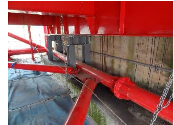
(b) 端横桁を支持する待ち受け工
