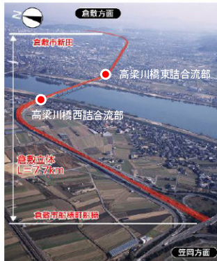
終点側より西方面(倉敷方面)を望む
