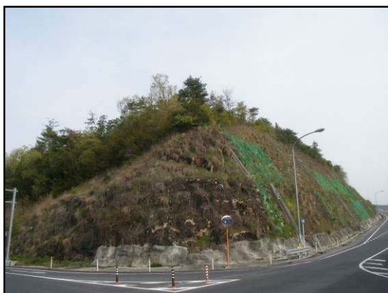
法枠による法面保護【対策前】
