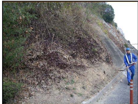
定期巡回(法面)
