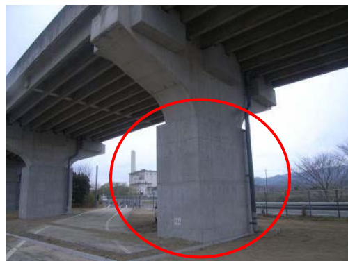
橋脚補強（RC巻立）【対策後】
