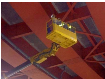
橋梁点検車による点検
