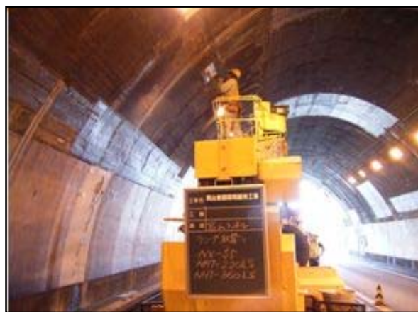
トンネル照明灯のランプ球替え
