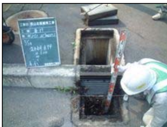
排水施設（構造物）清掃【清掃前】
