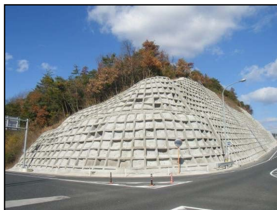
法枠による法面保護【対策後】
