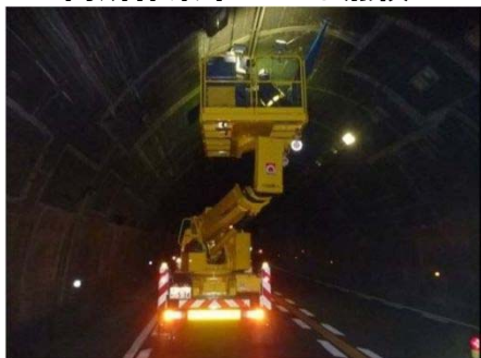
高所作業車による点検
