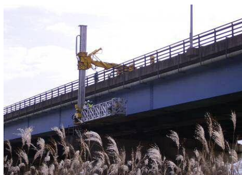
橋梁点検車による点検
