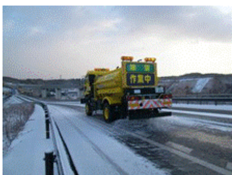
凍結防止剤散布作業
