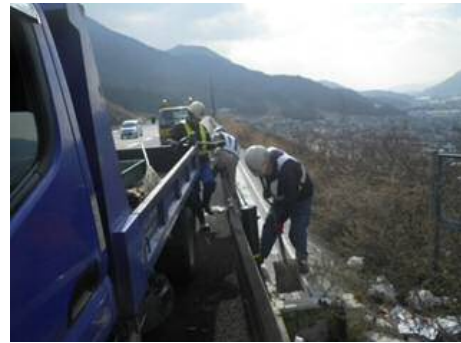
【側溝清掃】 清掃中
