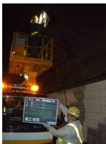
トンネル照明球替
