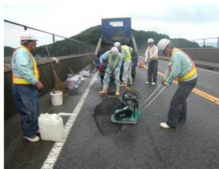
穴ぼこ（ポットホール）補修
