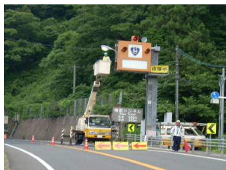
警報設備点検
