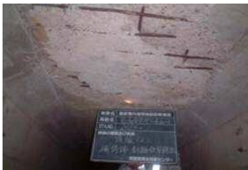
函渠下面の剥離・鉄筋露出
