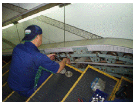
昇降機設備点検（エスカレーター）
