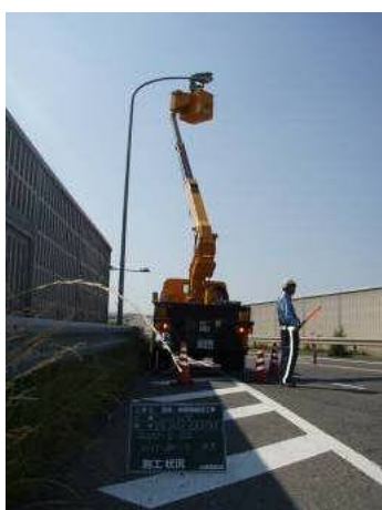
道路照明球替
