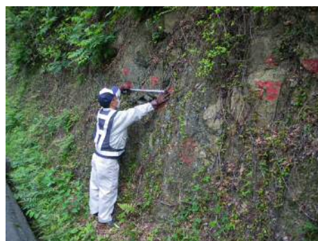
【定期巡回（法面）】
