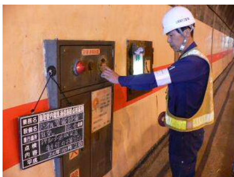
電気設備点検（トンネル警報設備）
