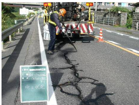
補修材（シール材）注入
