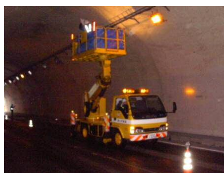
高所作業車による点検
