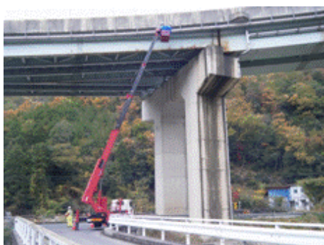
リフト車による橋梁点検
