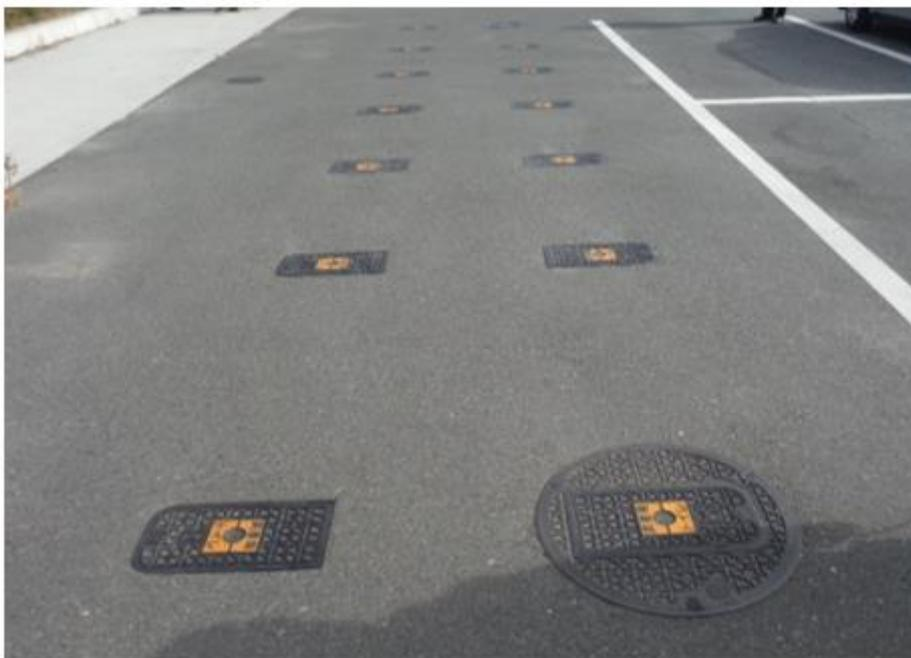
各々の鉄蓋のすぐ下に貯留槽があり、14個のトイレを設置できるようになっています。
