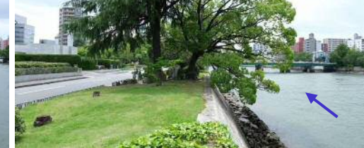
②堤防天端(本川橋下流)
