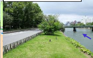
⑥堤防天端(本川橋上流)
