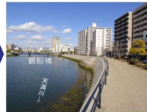
整備後(平成24年撮影)
