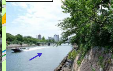
⑥護岸状況
