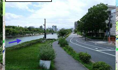
⑦堤防天端
