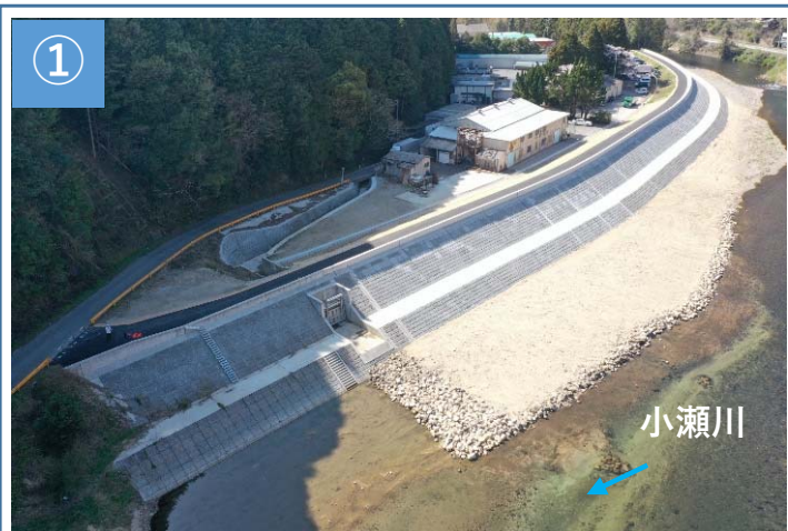
小川津地区堤防 完成時（令和7年3月末撮影）
