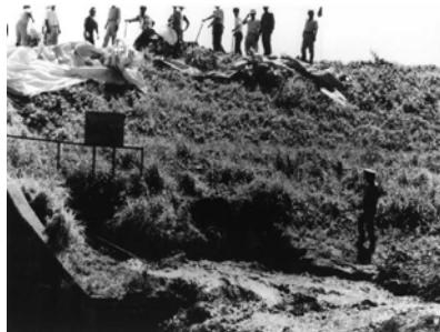
樋管からの漏水の事例
