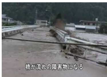
橋が川の流れと接触する事例 (足羽川 H16.7福井豪雨)
