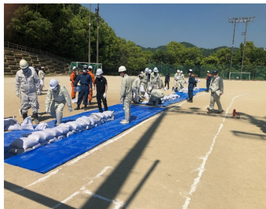
改良積み土嚢の作成
