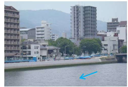
天満川右岸(1.0k~2.6k)の高潮堤防の整備状況 (広島市西区東観音町)
