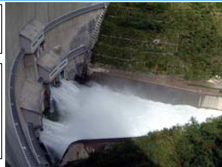
温井ダム常用洪水吐き操作時
