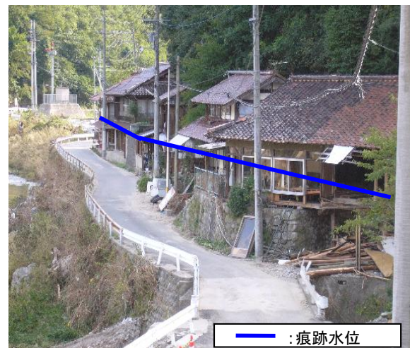
平成17年9月洪水被害状況
