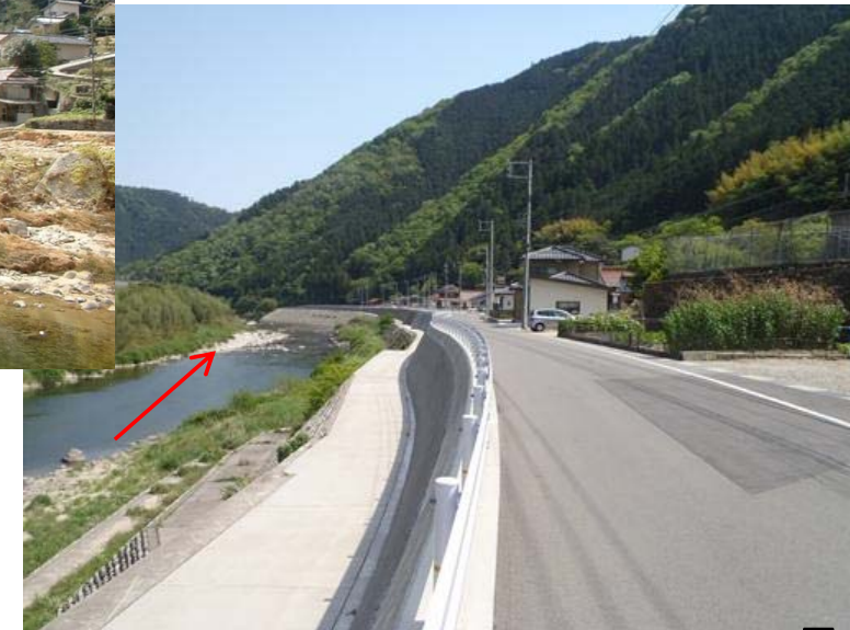
間野平地区整備後(平成27年5月撮影)
