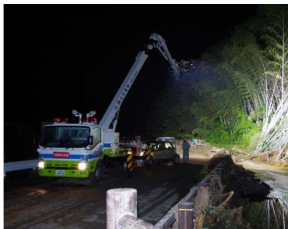
照明車の出動事例
