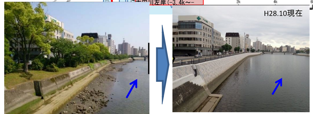
天満川左岸(1.5k~2.6k)の高潮堤防の整備状況 (広島市中区舟入町)
