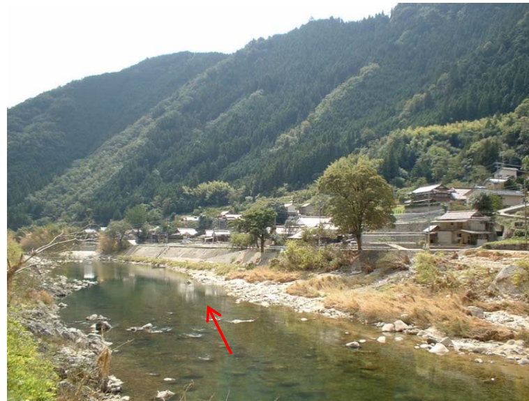
間野平地区整備前(平成17年9月洪水後)
