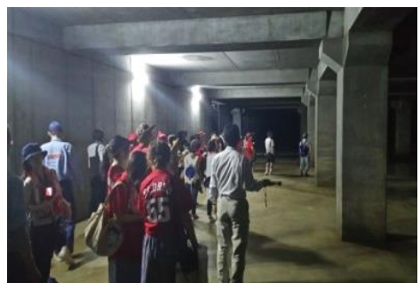
地下貯留地見学会
