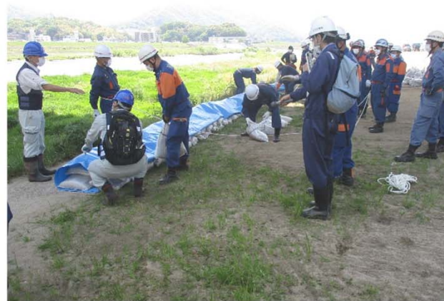
改良積土のうエ
