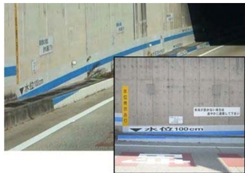
② アンダーパス道路側面への水位表示 （名古屋国道事務所）
