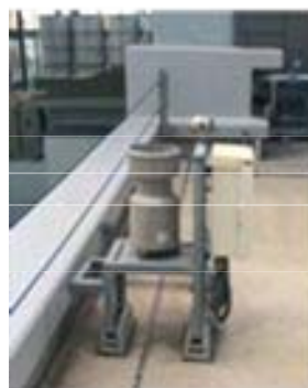
屋上へ雨量計設置
