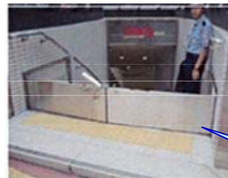
止水板、水防扉の設置
