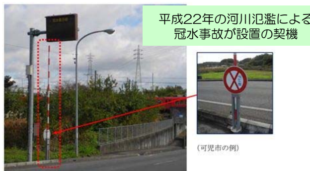
④ 道路冠水想定箇所に遮断器（さお型）を設置 （可児市）
