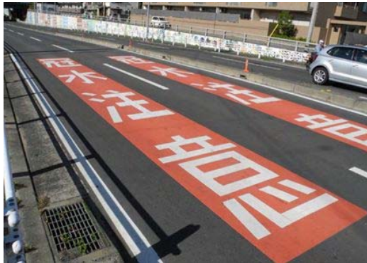
① 道路冠水想定箇所の路面に注意喚起（愛知県）
