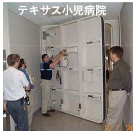
①浸水の伝搬防止を目的とした出入口及び地下空間への防水扉の設置
