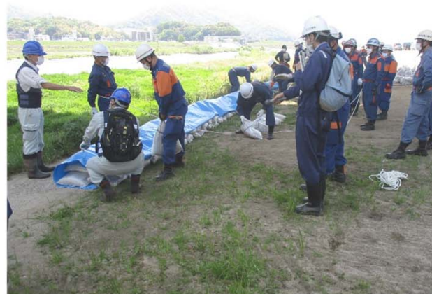
改良積土のうエ
