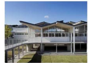
高床化による校舎への浸水対策
