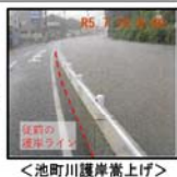
＜池町川護岸嵩上げ＞
