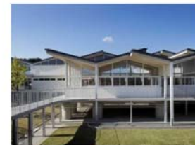
高床化による校舎への浸水対策
