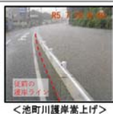
＜池町川護岸嵩上げ＞
