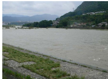
中島ポンプ場から下流側をのぞむ
