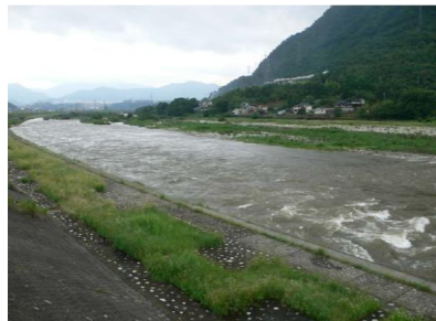
中島ポンプ場から下流側をのぞむ
