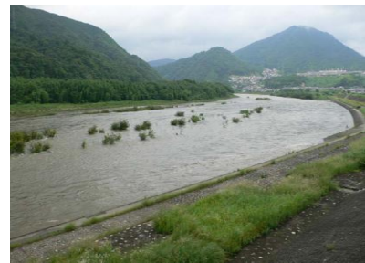
中島ポンプ場から上流側をのぞむ
