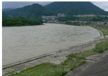
中島ポンプ場から上流側をのぞむ
