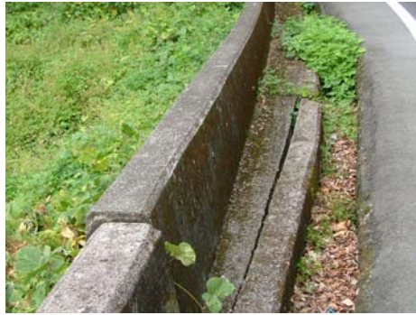
写真-5 堤防のズレとひび割れ
