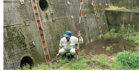
堆砂量や水抜き穴、コンクリートのひび割れなどを確認
