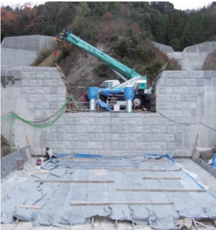
流木捕捉工の整備が進む四季が丘7号砂防堰堤工事(廿日市市)
