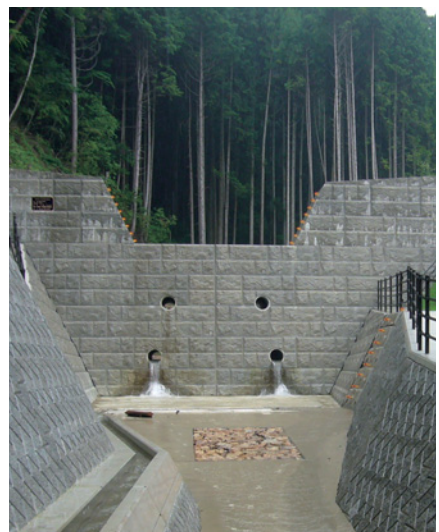
川角2号砂防堰堤(広島市佐伯区 5月完成)
