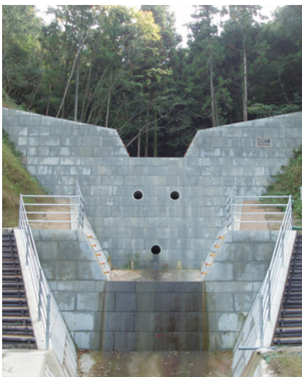
武田山2号砂防堰堤(広島市安佐南区 6月完成)
