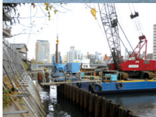
沈下対策矢板の施工の様子 (平成22年12月9日撮影)
