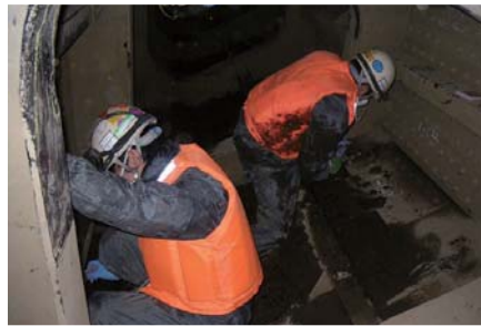
ゲート内調査の様子
