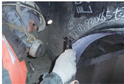
腐食箇所計測の様子
