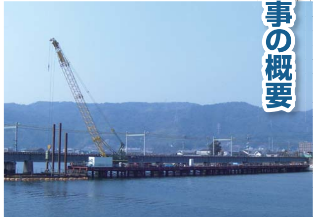
鉄橋撤去工事の様子
