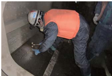
リベット打音調査の様子
