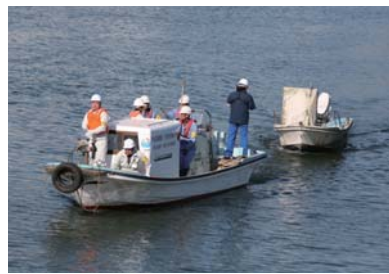
撤去作業の様子
