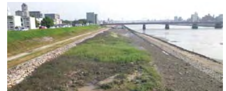
太田川放水路已斐橋下流東岸
