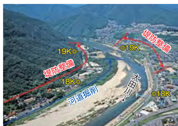
太田川下流部の整備予定箇所(広島市安佐北区可部付近)
