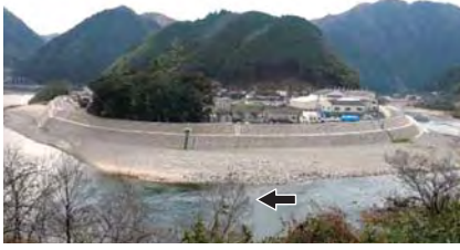
太田川堤防整備箇所(広島市安佐北区安佐町筒瀬地先)
