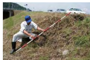
出水期前点検の様子
