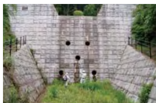
砂防堰堤点検の様子
