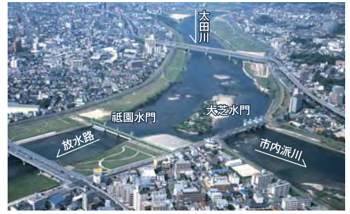
太田川放水路と市内派川の分派地点
