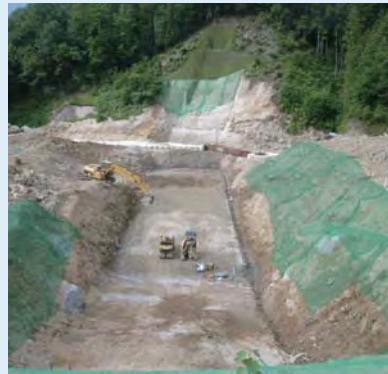
宮内2号砂防堰堤 掘削後
