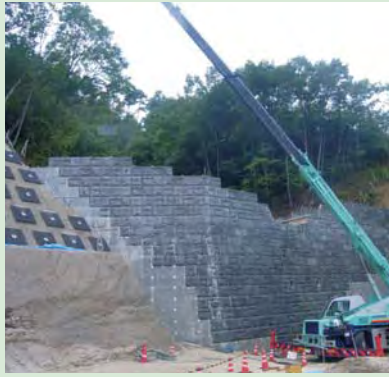
あさひが丘4号砂防堰堤工事（堰堤部コンクリート打設）
