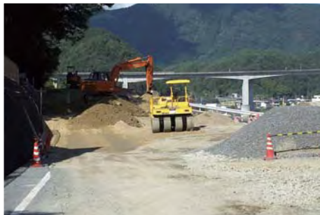
堤防のかさ上げを施工中
