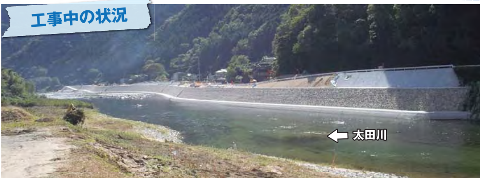
川平地区（広島市安佐北区安佐町後山）工事延長 約580m
