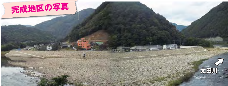
おおむね完成した柳瀬地区（広島市安佐北区可部町今井田）工事延長 約475m
