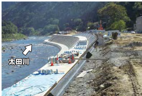
護岸工を施工中
