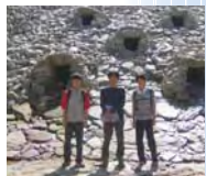
白糸川1号砂防堰堤
