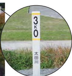
▲堤防に設置している距離標柱
