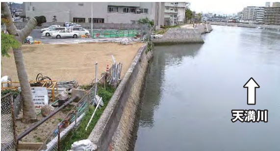
▲施工前の様子
