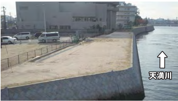
▲完成した高潮堤防 広島市中区舟入本町 平成23年11月29日撮影
