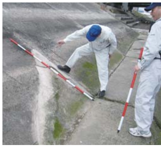
▲出水期前堤防点検実施の様子
