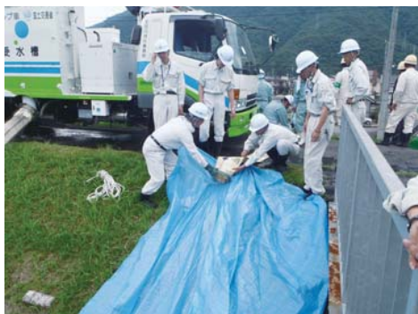
▲排水機場の試運転の様子
