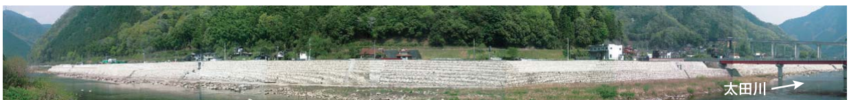
▲姫瀬・毛木地区の床上浸水対策事業の様子
