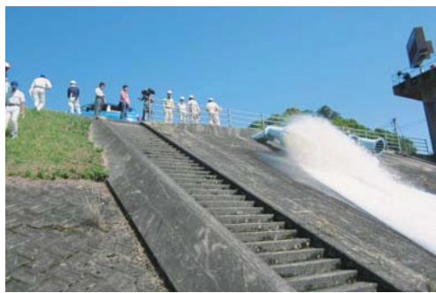
▲排水機場の試運転の様子
