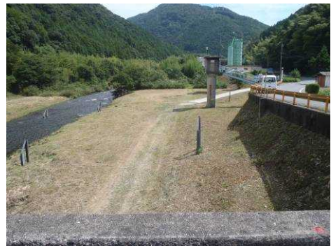
(流量観測所除草後)
