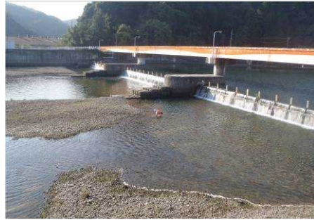
H30 中市堰掘削工事前
