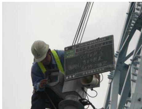
CCTV カメラ点検状況
