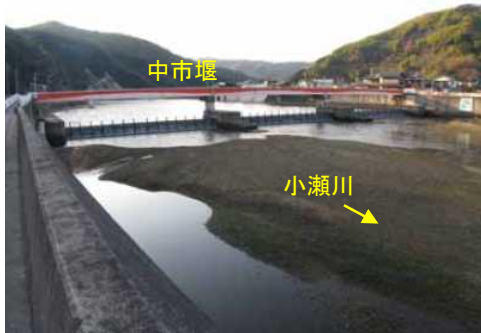
土砂堆積状況 (H22 年 1 月)
