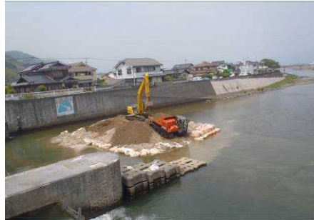
H30 中市堰掘削工事 (H30 小瀬川管内維持工事)
