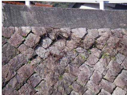
管理区間上流部の空石積護岸
