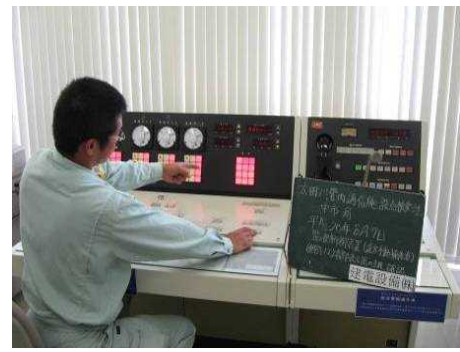
放流警報装置点検状況
