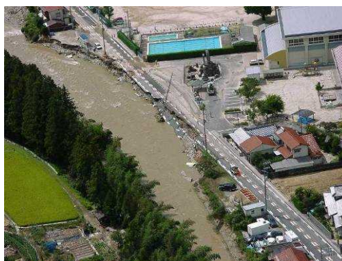
図 3-8-1 H17.9洪水 玖島川の被災状況（広島県廿日市市）
