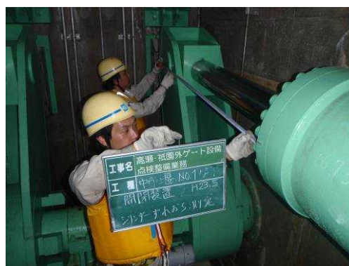
図 5-3-7 機械設備の点検 (中市堰)
