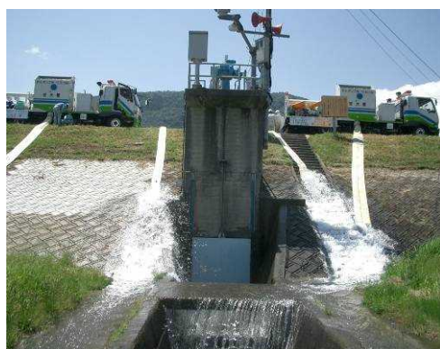
排水ポンプ車操作訓練
