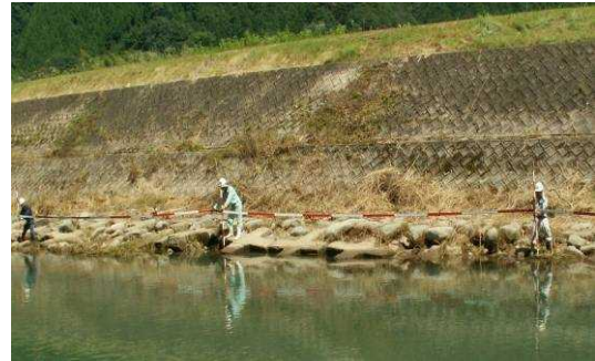
図 6-4-3 出水後の点検
