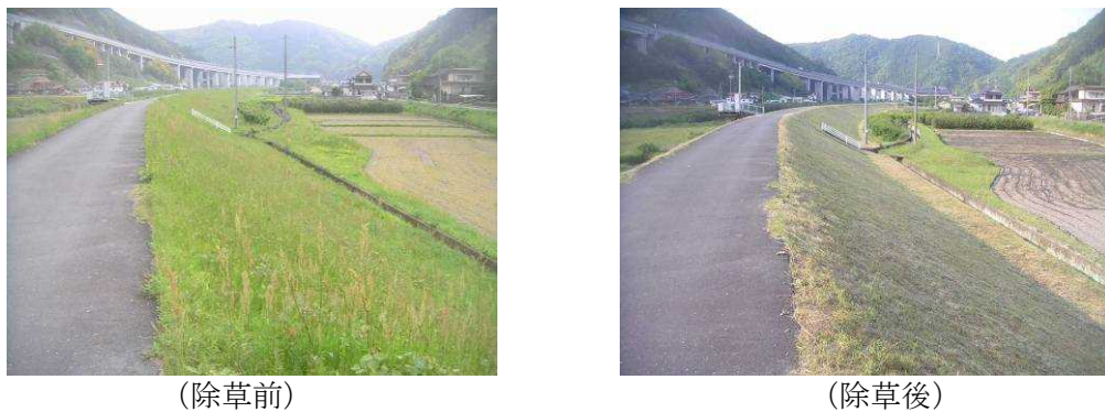
図 6-2-1 堤防除草前後の写真
