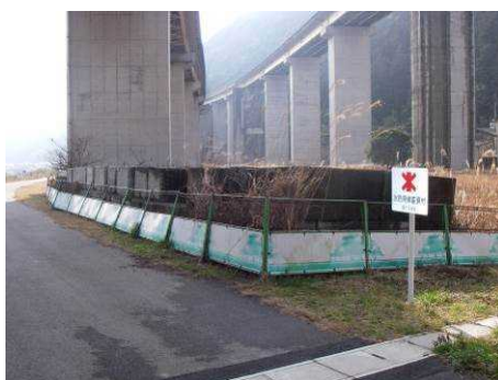
図 5-6-1 水防資材の備蓄
