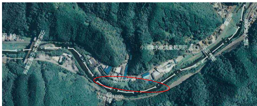
図 5-2-4 無堤部の保護のための樹木 (10K780～11K470 右岸)
