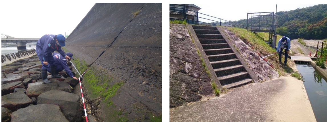
図 5-3-4 堤防点検の状況
