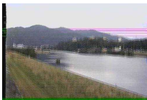
カメラ装置劣化による画像の乱れ
