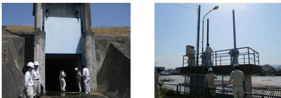
図 6-4-7 許可工作物の点検（太田川事例）
