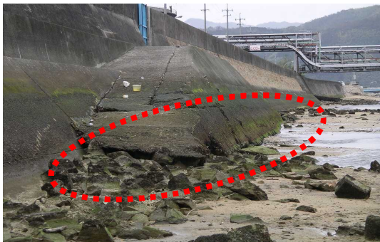
護岸基礎部を保護する根固めが散乱し基礎が露出した事例(小瀬川) 損傷箇所は復旧済み
