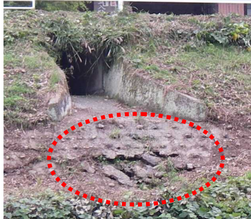
空石積護岸の補強コンクリートが剥離している事例
