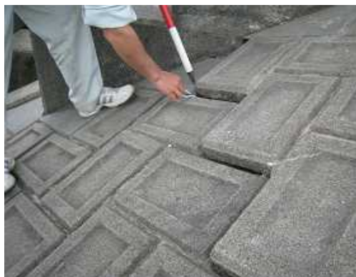
樋門周辺護岸の沈下が発生
