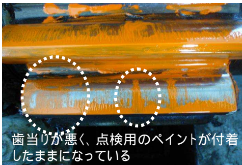
更新年次を迎えた樋門の不具合事例
